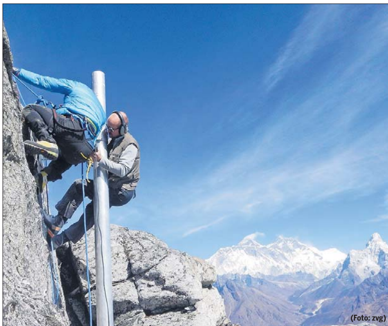
Patrick Kalbermatten (rechts) bei der Antennen-Installation in Nepal.
