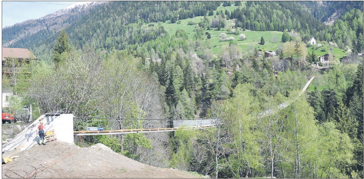
280 Meter lang und bis zu 92 Meter hoch spannt sich die Hängebrücke über die Lammaschlucht und verbindet Fürgangen mit Mühlebach.
