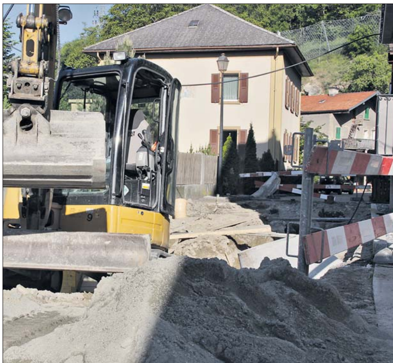
Baustelle. Hier hindurch führt der Schulweg der Primarschüler und Kindergärtner.
