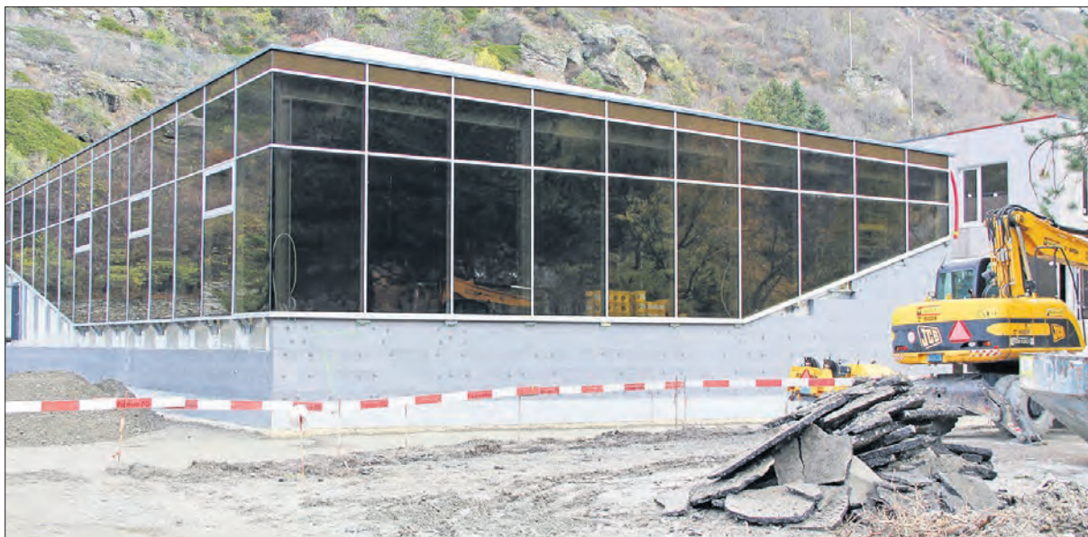
Eine Baustelle. Vor dem Thermalbad Brigerbad deutet zurzeit wenig darauf hin, dass an Silvester eine Eröffnung stattfindet.
