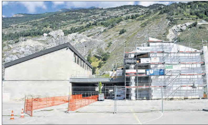
Das Schulhaus in Niedergesteln wird in zwei Phasen aufwendig saniert und den heutigen Standards angepasst.
