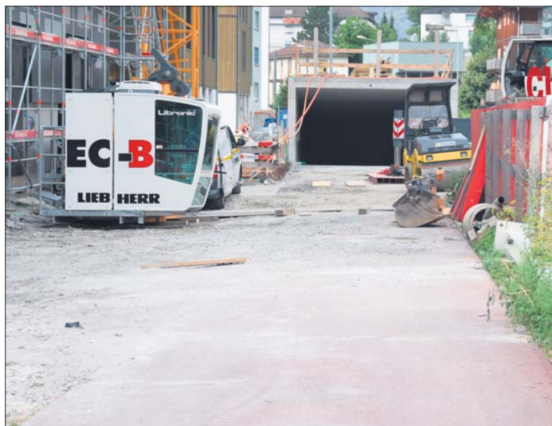
Die Ein- und Ausfahrt in das Parkhaus bei der Grossbaustelle «Aletsch Campus».
