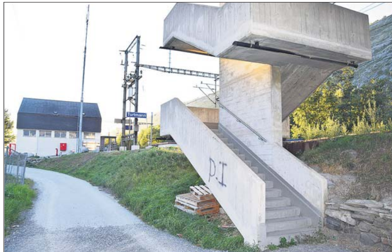
Der Treppenabgang am Bahnhof in Turtmann wird demnächst beleuchtet.
