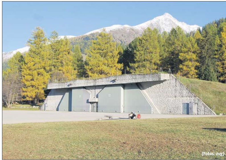
Hier soll eine beheizte Eventhalle für diverse Anlässe mit Garderoben sowie ein neuer Werkhof für die Loipe Goms entstehen.
