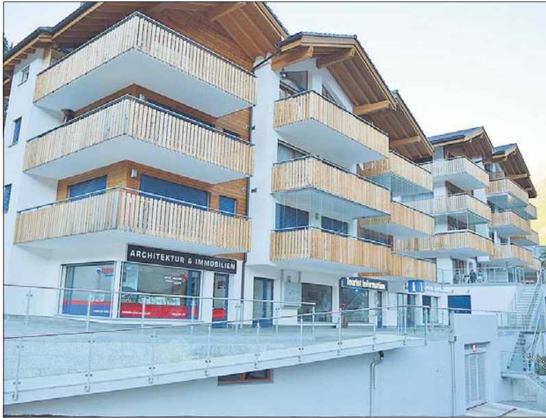
Im Haus Atlantis soll das neue Lebensmittelgeschäft eröffnet werden.
