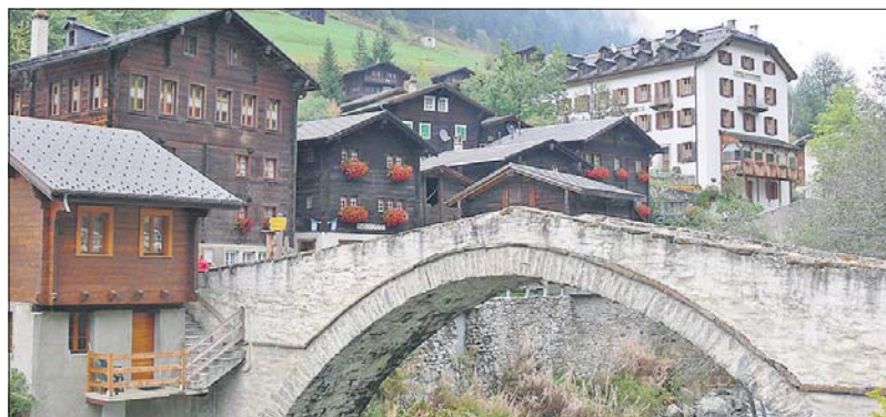
Das Schulgebäude in Binn muss saniert werden.
