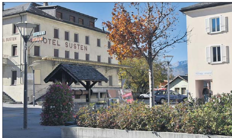
Die Bauarbeiten am neuen Dorfplatz beginnen diesen Herbst.
