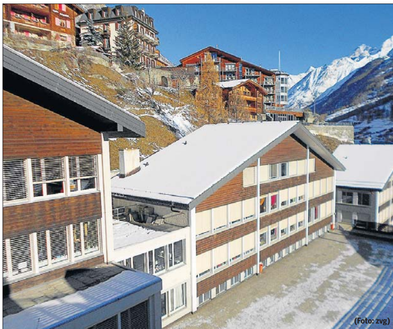
Die drei Zermatter Schulgebäude «Walka» sollen abgerissen und neu gebaut werden.
