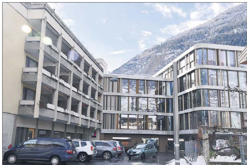
Der alte Trakt des Martinsheims in Visp soll durch einen Neubau ersetzt werden.
