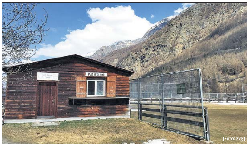
Die Baracke beim Fussballplatz in Täsch wird wohl bald wieder der Gemeinde gehören. (Foto: zvg)
