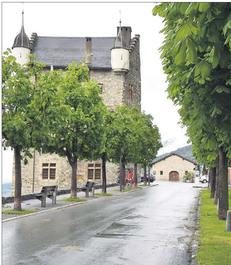
Soll schon bald in neuem Glanz erstrahlen – der Rathausplatz von Leuk.
