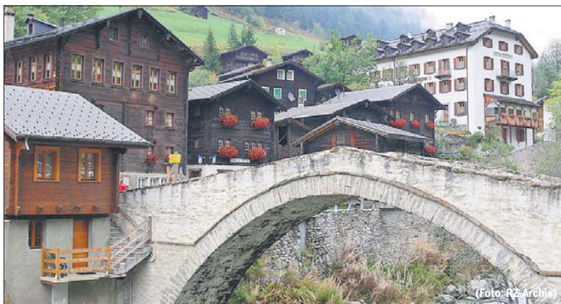
Das mehrstöckige Schulhaus in Binn (links neben der Brücke) muss saniert werden.
