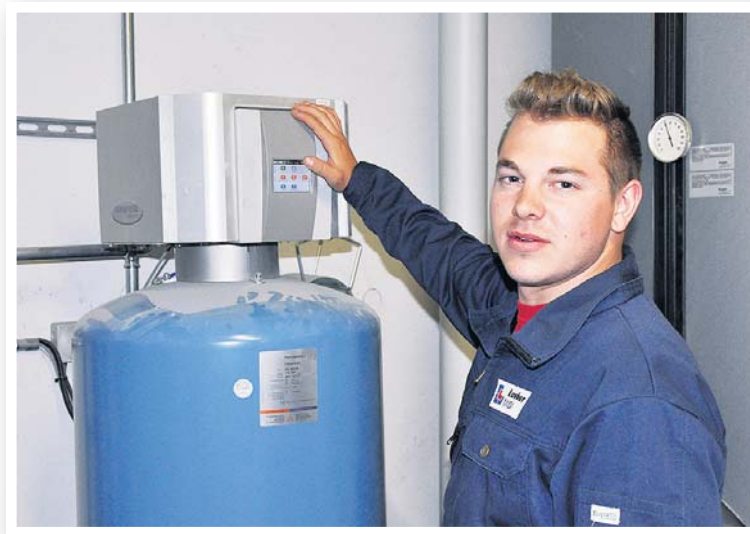
Joël Abgottspon, Heizungsinstallateur im 2. Lehrjahr bei Lauber Iwisa.
