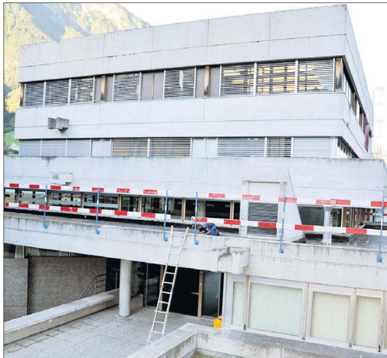
Die Arbeiten an der Berufsfachschule Oberwallis in Brig werden 2017 abgeschlossen.
