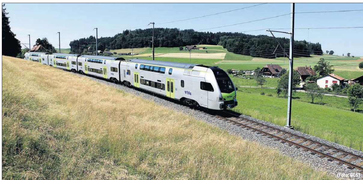
In der neuen Werkstatt sollen vor allem S-Bahn-Kompositionen gewartet werden. Damit scheidet das Oberwallis als Standort aus.
