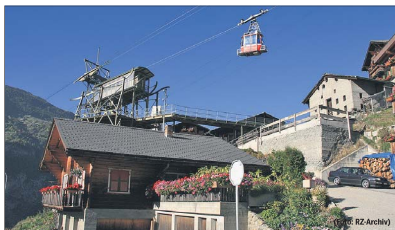
In Staldenried werden demnächst zahlreiche neue Projekte realisiert.
