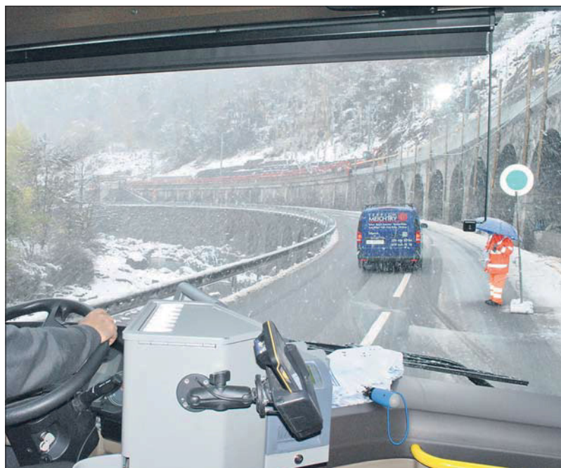
Auch bei Regen und Schnee gewährleisten Securitas-Mitarbeiter dem Postauto pünktliches Vorwärtskommen an der Baustelle.
