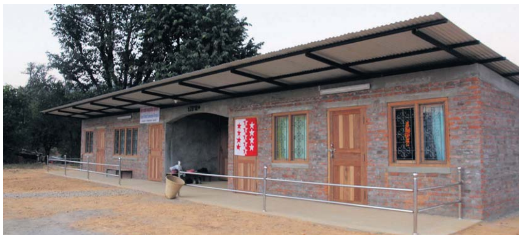
Die Krankenstation nördlich von Kathmandu ist fertiggestellt: Ein Segen für die Menschen in der Region.
