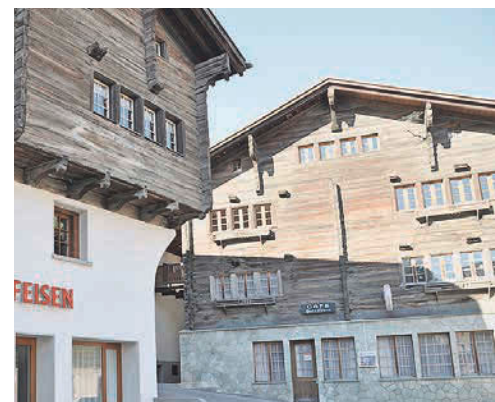
Das leer stehende Restaurant Bettlihorn könnte beim Hotelprojekt wieder genutzt werden.
