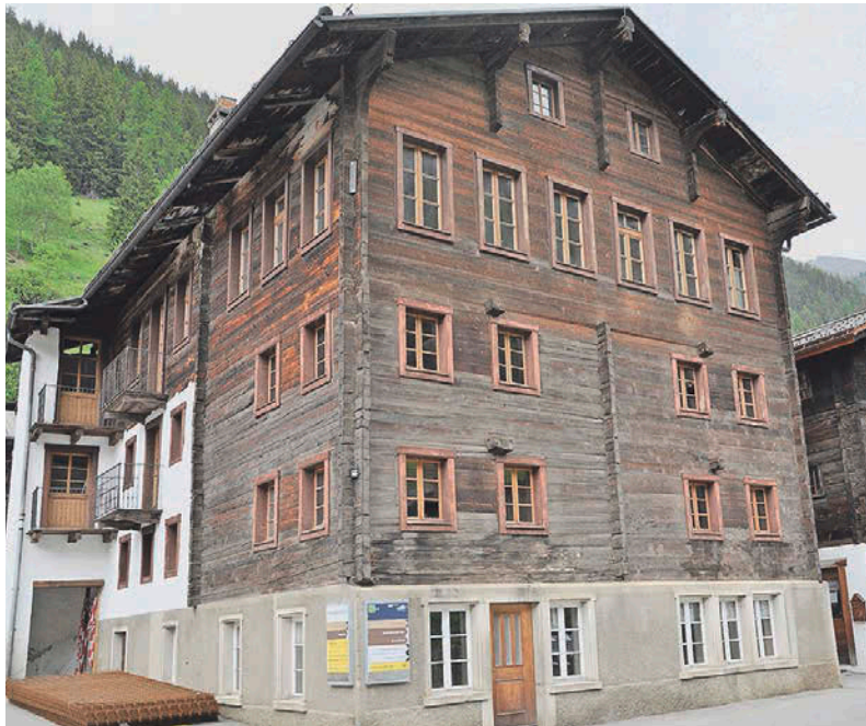
Die renovierten Schulräumlichkeiten sollen 2018 bezogen werden können.
