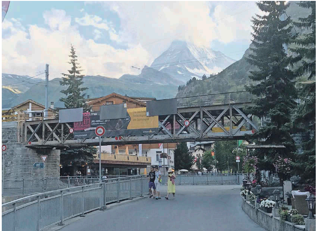
Die 120-jährige Getwingbrücke wird zwar abgerissen, danach aber wieder im Einsatz sein.
