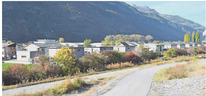
Ein Anergienetz wärmt und kühlt seit zehn Jahren die Gebäude in Visp West.
