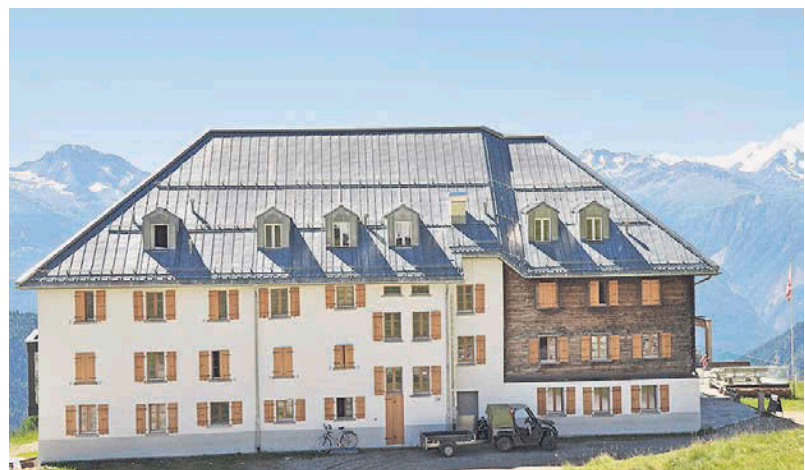
Die alten Zimmer im Hotel Belalp sollen im Belle-Époque-Stil saniert werden.
