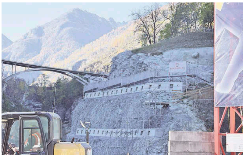
Die Plattform (Bildmitte) oberhalb der Baustelle der Umfahrung von Stalden.
