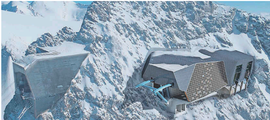
Klein Matterhorn: Die bestehende Bahn (links), die sich im Bau befindliche Station (Mitte) und das geplante Projekt (rechts).
