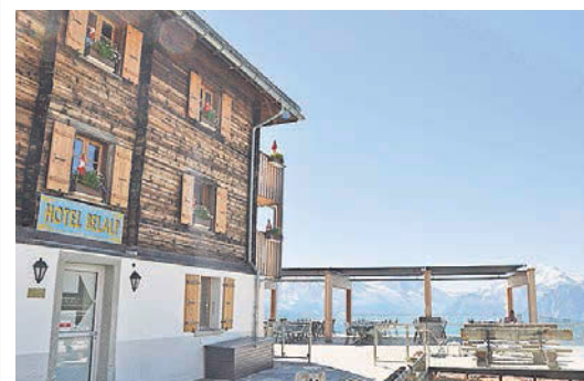
Das Hotel Belalp wird renoviert.
