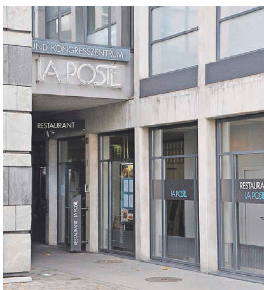
Das Restaurant La Poste wird erneuert.
