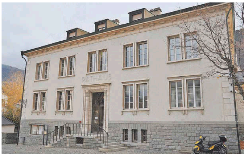
Der Dachstock im Visper Rathaus muss saniert und umgebaut werden.
