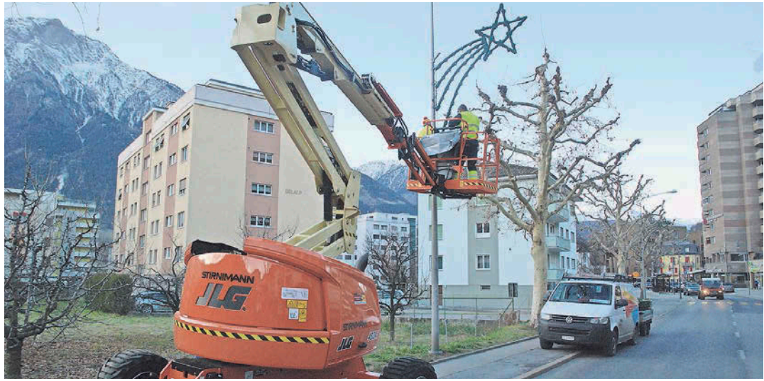
In Naters wurde diese Woche die Weihnachtsbeleuchtung montiert.
