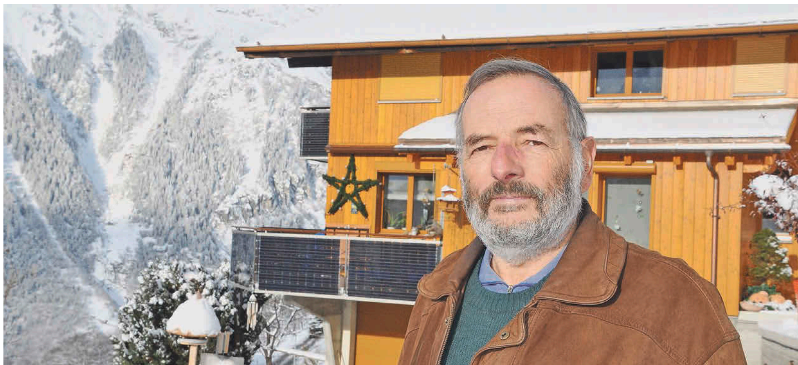
Ruedi Lehmann vor einem Haus in Bellwald, mit im Balkongeländer integrierten Photovoltaikpanels.
