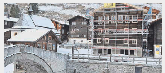
Das Schulgebäude in Binn wird renoviert.
