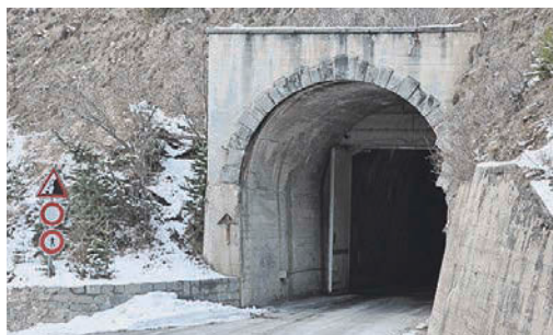
Das Wettertor im Binntaltunnel.
