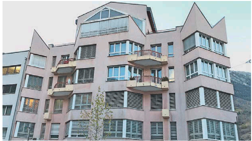
Ansicht alte Fassade Süd.
