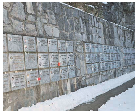
Bei den Urnennischen soll Ende Dezember/Anfang Januar ein Kerzenhaltersockel errichtet werden.
