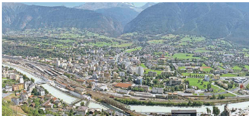
In Brig-Glis tut sich wieder etwas in Bezug auf Geothermie.
