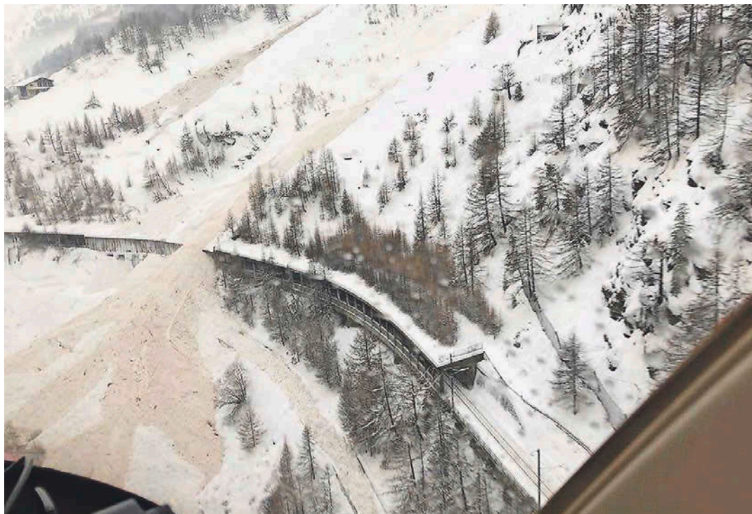
Auf der Strecke zwischen Täsch und Zermatt ist das Bahntrasse beim Abschnitt «Schusslowina» durch eine Galerie geschützt. Die darunter verlaufende Strasse hingegen nicht.
