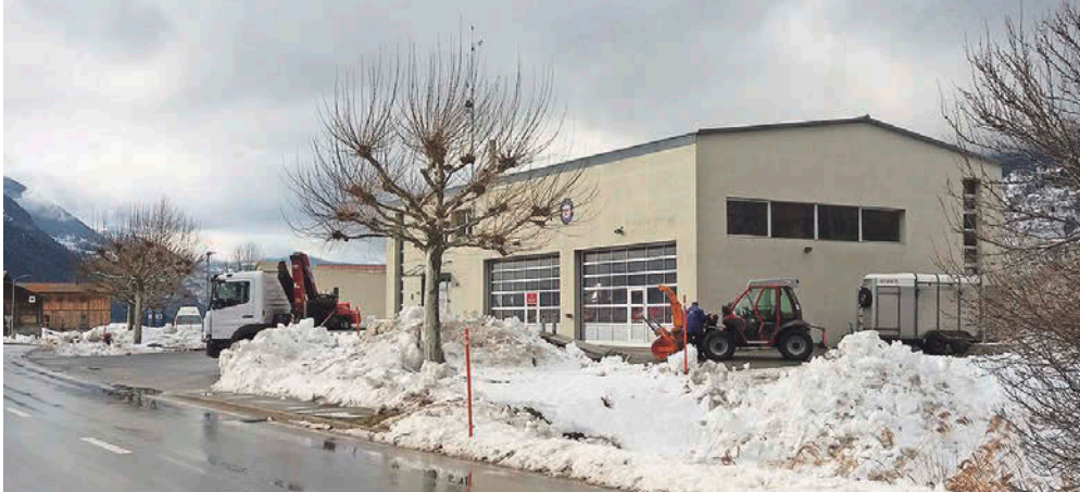
Auf dem Dach des Ried-Briger Feuerwehrlokals ist eine weitere Mobilfunkantenne geplant.
