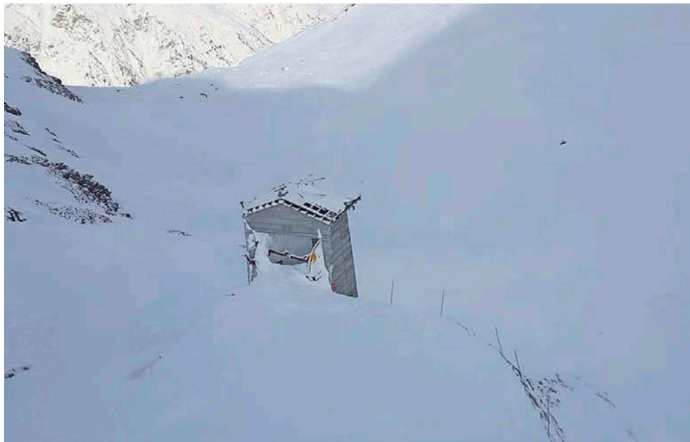
Die von einer Lawine zerstörte Talstation des Sessellifts «Kumme» in Zermatt.
