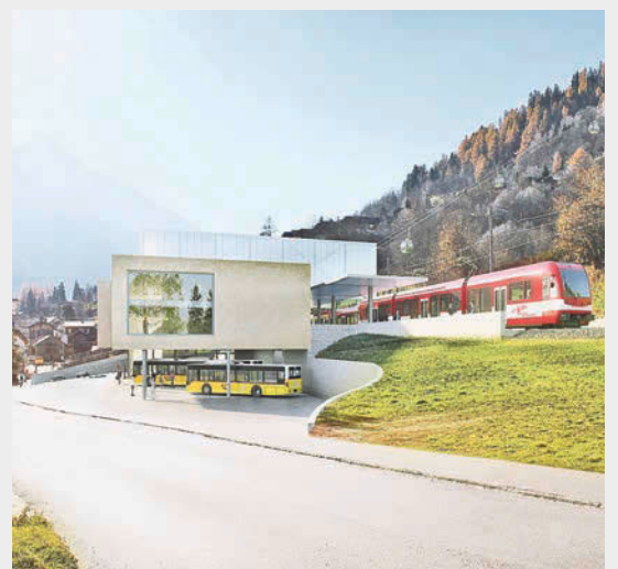
Der neue Fiescher Bahnhof mit integrierter Gondelbahn auf die Fiescheralp.
