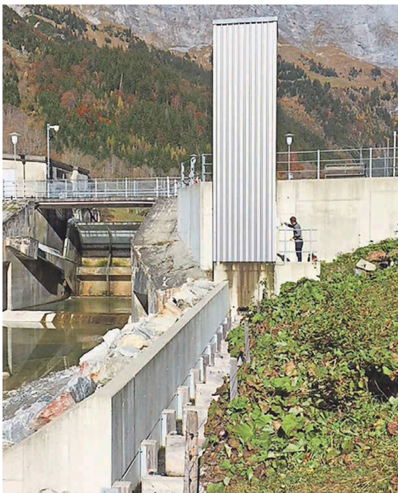
Dieser Fischlift im Berner Oberland (Gadmerwasser beim Sustenpass) funktioniert seit drei Jahren und wird jährlich von 350 Fischen benützt. Foto zvg
