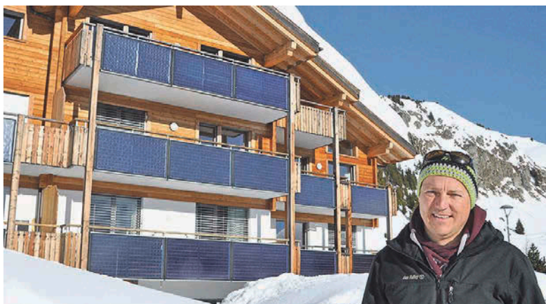
Gemeinderat Andreas Walker steht vor einem Gebäude, welches mit thermischen Solarkollektoren ausgestattet ist.
