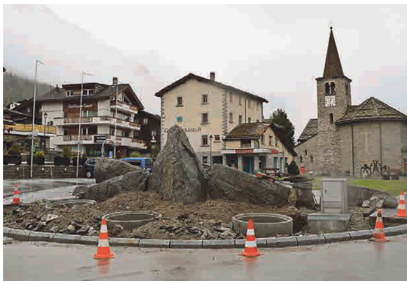
...sind entfernt worden und werden durch drei neue ersetzt.
