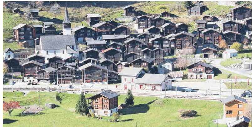
Der Bahnhof Niederwald (Bildmitte) wird später umgebaut.
