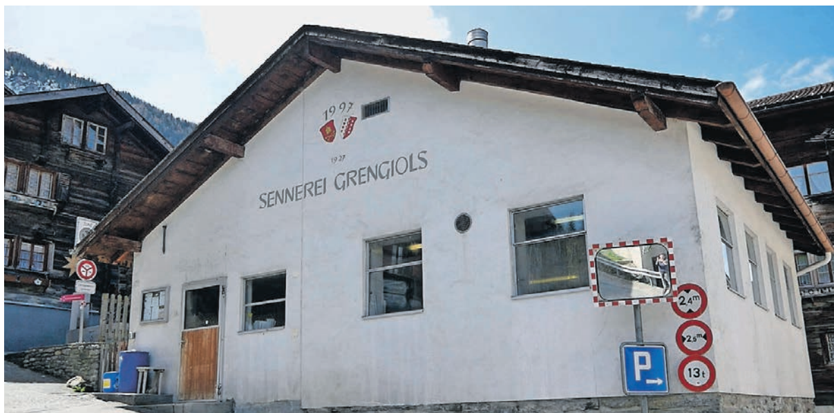
In Grengiols soll eine neue Sennerei gebaut werden.
