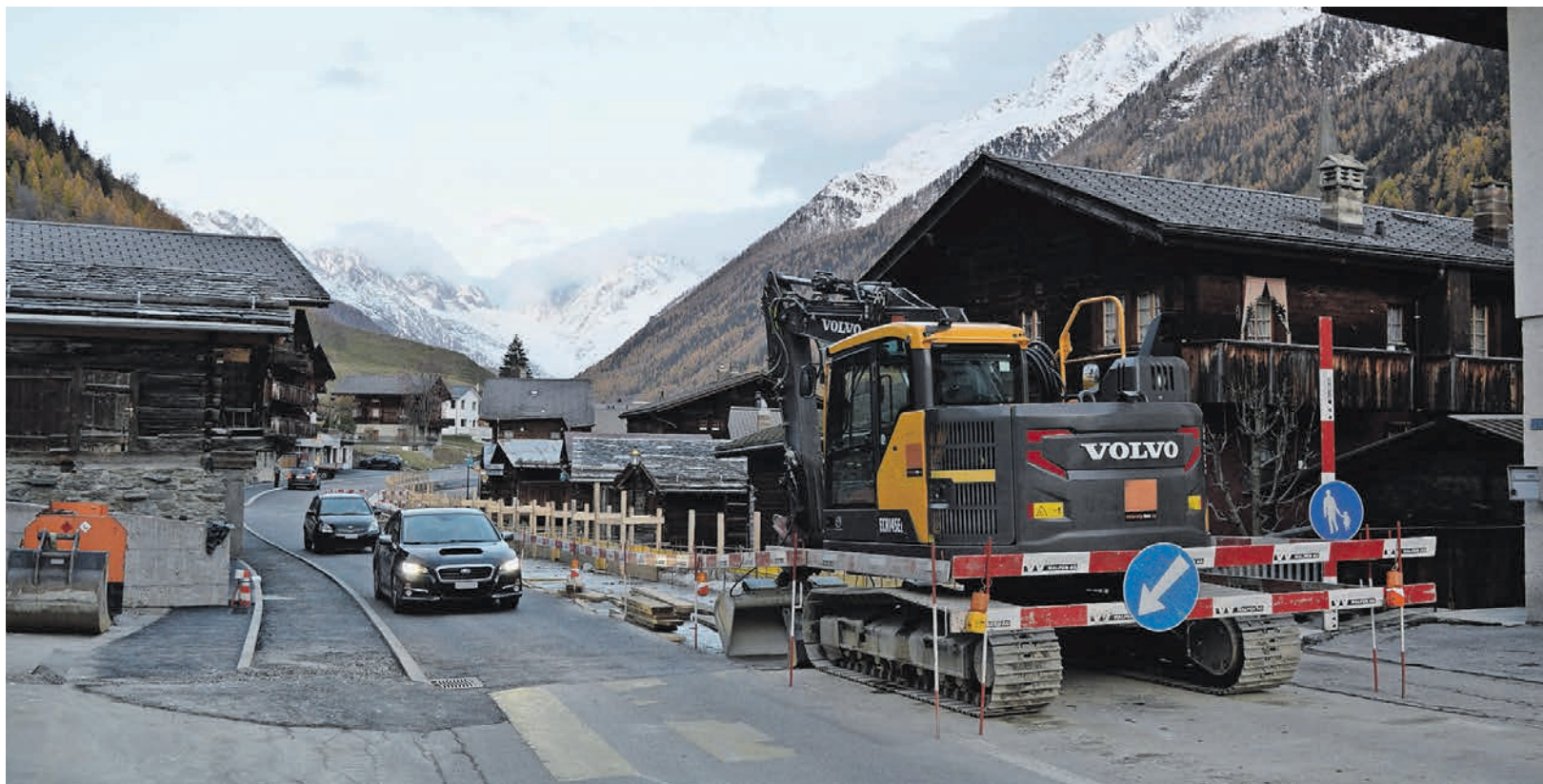
Die Arbeiten sind im Zeitplan. In diesen Tagen wird der erste Teil der Sanierung der Strasse in Kippel abgeschlossen.
