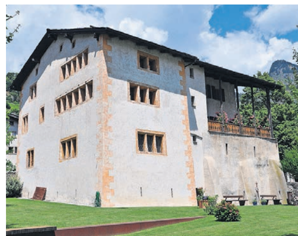
Das Pfarrhaus Naters wird saniert.
