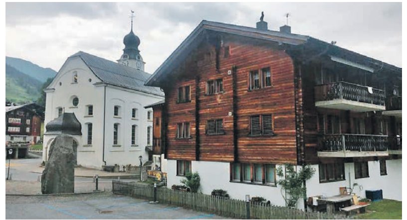
Das leer stehende Gemeindebüro von Reckingen (Erdgeschoss) ist eines von mehreren Objekten, welche die Gemeinde Goms verkaufen will.
