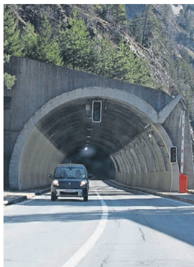
Im Mittaltunnel wird gearbeitet.
