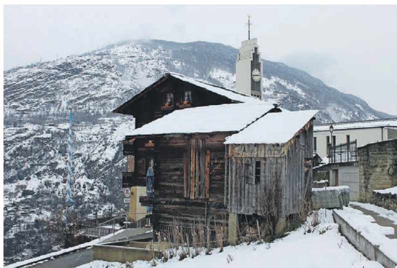
Zur Ortsbildverschönerung will die Gemeinde auf ihrem Grundstück bei der Kirche den rechten Stallanbau sowie den Misthof entfernen lassen.
